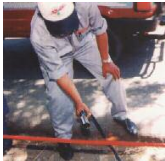
Pemasangan HEPTI 2-15 dengan menurunkan kawat udara
